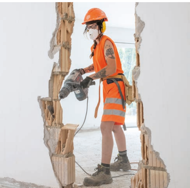
▼ Sharon Danesi abat une paroi intérieure en briques à l'aide d'un marteau-piqueur.
